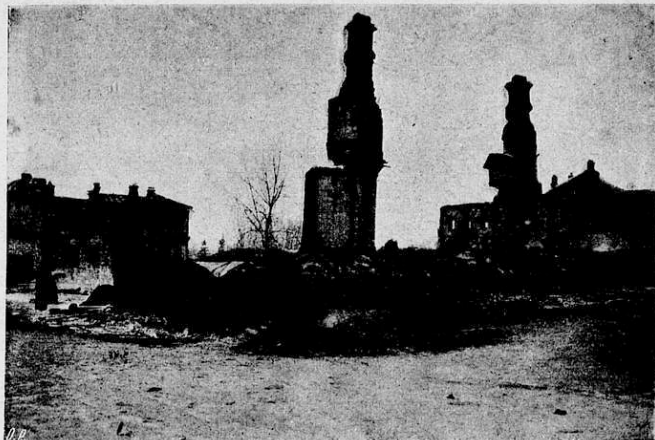
„Декабр. кровав. дни въ Москвѣ“. Остатки фабрики Шмидта.
